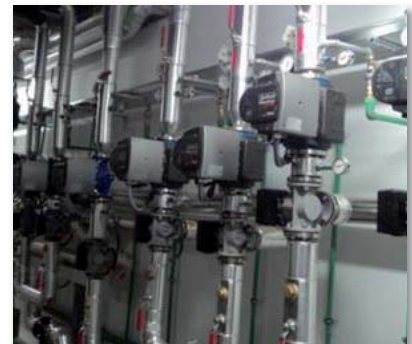
Inclusión de bombas con variador de velocidad. Producción centralizada de calor y sectorización. Medidas de energía para cada servicio y en cada productor
